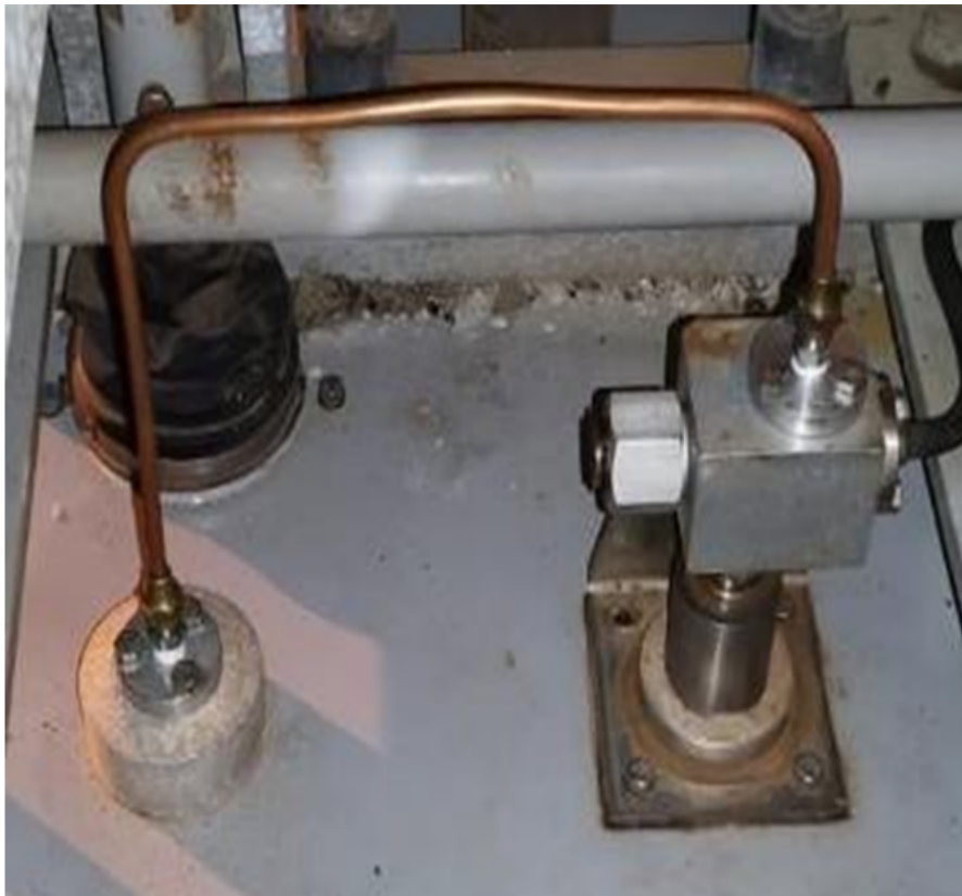
Figura 12. Ponto do vazamento do Disjuntor 05.
