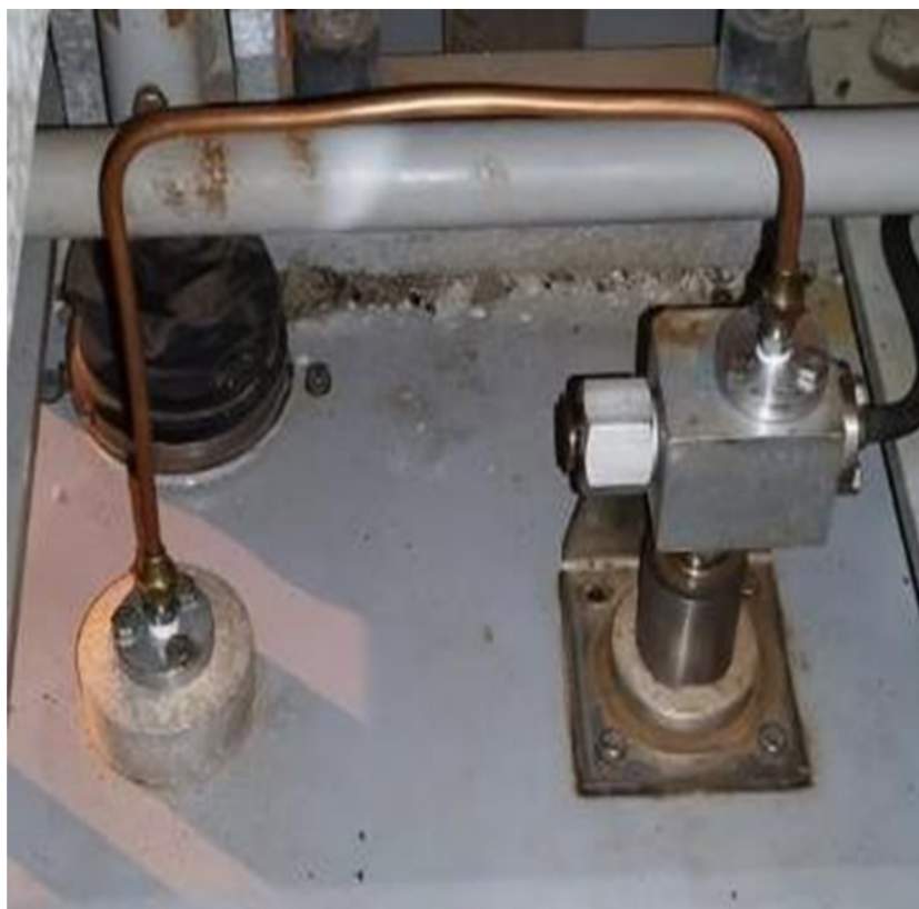
Figura 10. Ponto do vazamento do Disjuntor 04.
