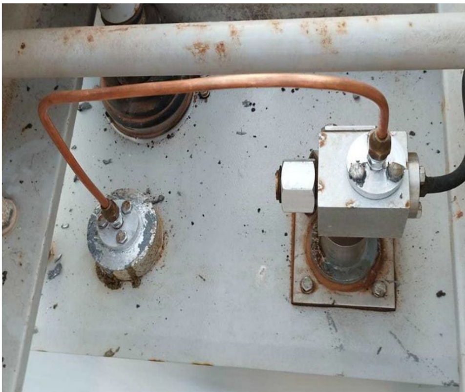
Figura 9. Produto vedante aplicado no Disjuntor 03.
