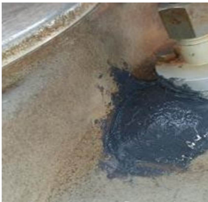
Figura 7. Produto vedante aplicado no Disjuntor 02. Tabela 2. Características do gás isolante do Disjuntor 02.
