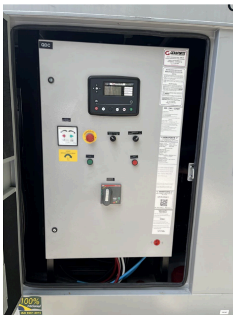
Figura 08 - Layout externo do painel de comandos
