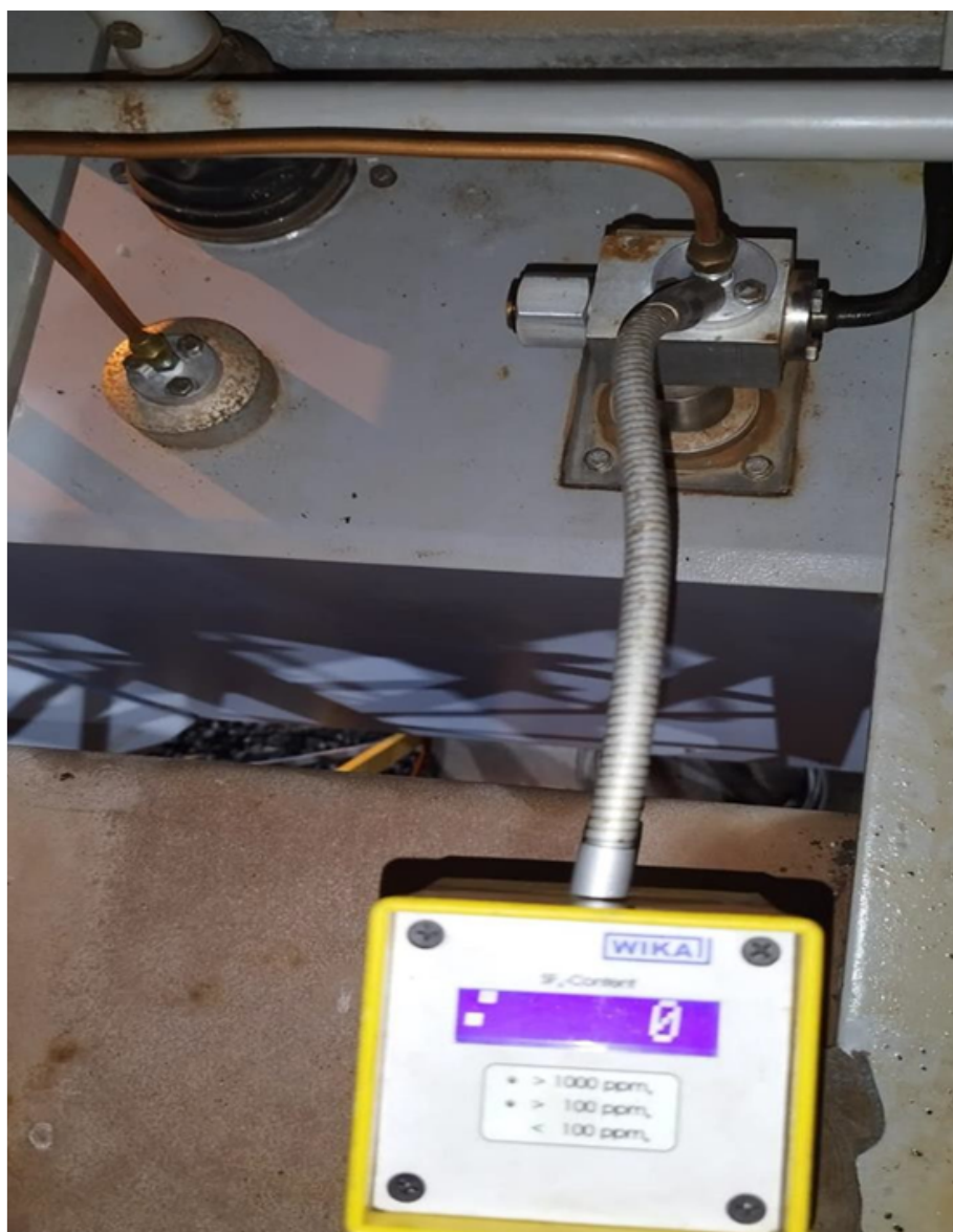
Figura 13. Produto vedante aplicado no Disjuntor 05. Tabela 5. Características do gás isolante do Disjuntor 05.
