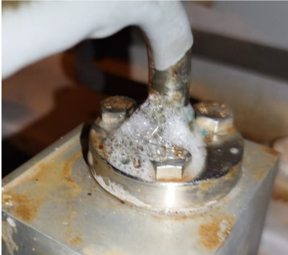
Figura 8. Ponto do vazamento do Disjuntor 03.
