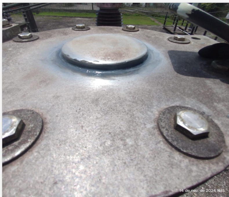
Figura 5. Produto vedante aplicado no Disjuntor 01.
