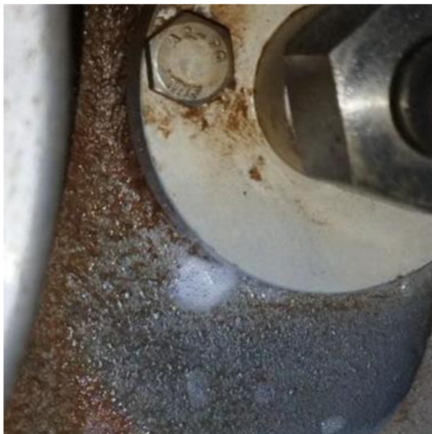
Figura 6. Ponto do vazamento do Disjuntor 02.
